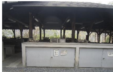
鉄扉のごみ収納庫
